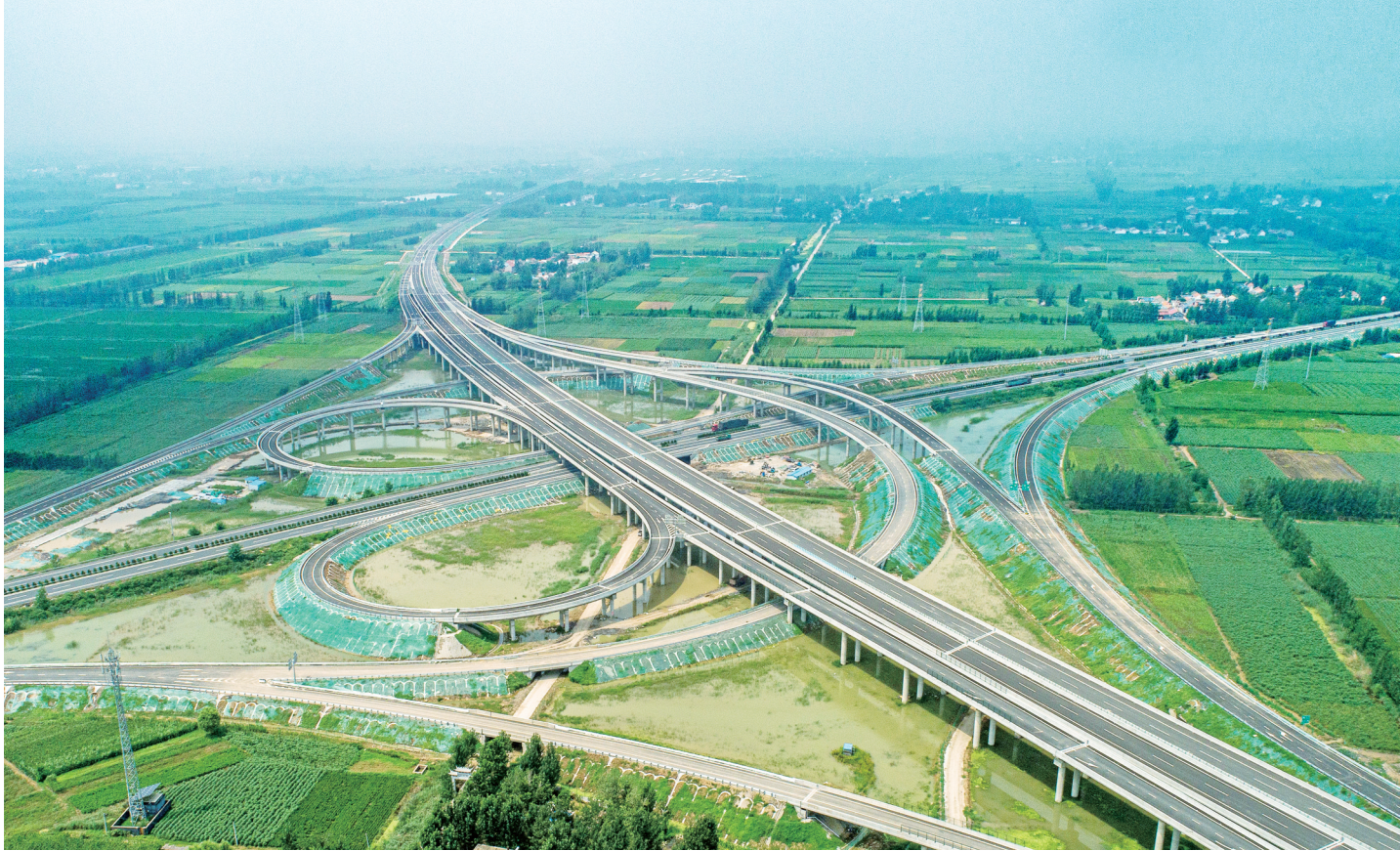
枣菏高速的通车,将与京台、济徐等5条高速公路实现互联互通,对地方经济发展起到巨大拉动作用。 ■记者 杨国庆 通讯员 李宁 摄
