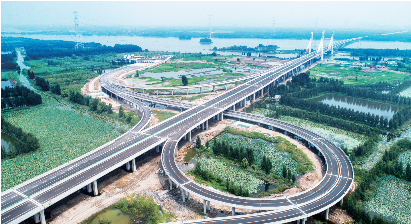
图为空中俯瞰微山湖特大桥南阳互通立交。
