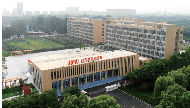
嘉祥县九如城医养综合体项目
