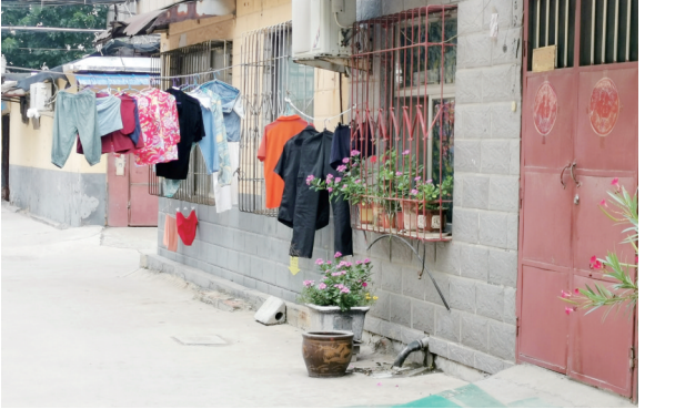
在太白湖新区车站南路东侧儿童公园附近，道路护栏出现多处破损，需要有关方面及时更换修复。 ■记者 陈硕 摄 20200782号
