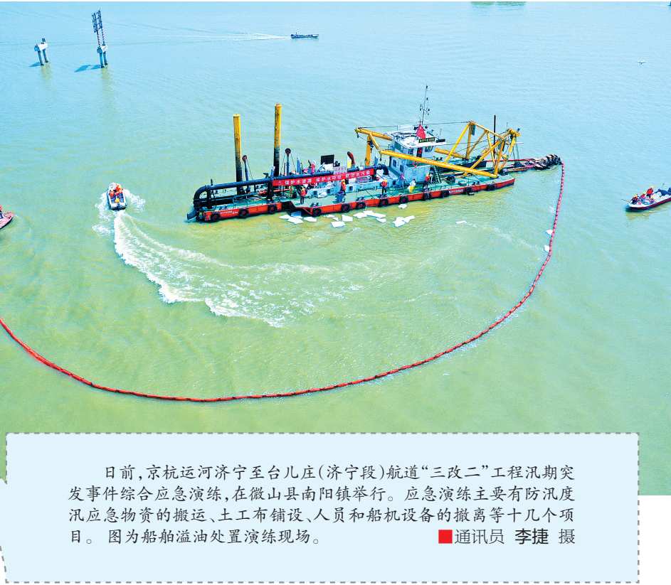
日前,京杭运河济宁至台儿庄(济宁段)航道“三改二”工程汛期突发事件综合应急演练,在微山县南阳镇举行。应急演练主要有防汛度汛应急物资的搬运、土工布铺设、人员和船机设备的撤离等十几个项目。图为船舶溢油处置演练现场。
