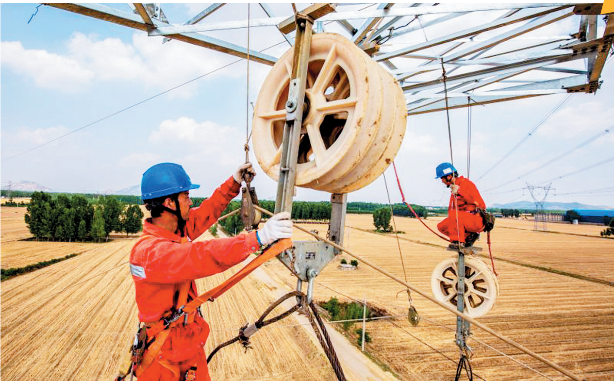
6月10日,国网济宁供电公司员工在220千伏邹宿线5号塔开展放线作业,加快推进济宁东部电网建设,为曲阜、邹城、泗水等五个县市区提供坚强电力保障。 ■通讯员 王者东 摄
