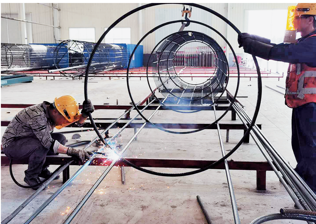
济南至微山高速公路是山东省高速公路网的重要组成部分，可联通董梁、日兰、枣菏三条东西向高速公路，并快速连接济宁新机场、鲁南高铁济宁东站，完善我市区域路网布局、优化路网结构，形成科学高效的综合交通运输体系。图为济微高速公路兖州段桩基钢筋笼加施工现场。
