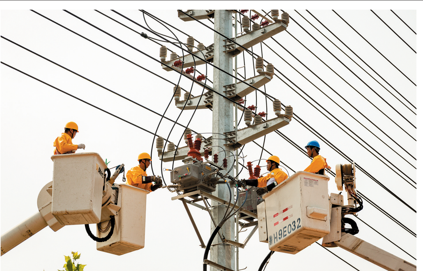
虽已立秋,气温却居高不下,用电负荷不断攀升。为确保辖区内群众正常用电、企业正常生产,嘉祥县组织电力部门定期对电网设备进行检修,查找和消除各种隐患,全面掌握电网设备运行状况,为电网设备安全稳定运行打下坚实基础。图为供电公司员工正在对线路进行检修。 ■通讯员 王者东 摄
