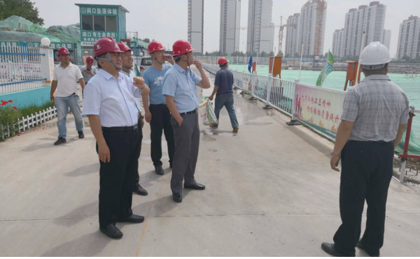
市住建局领导检查工地。
