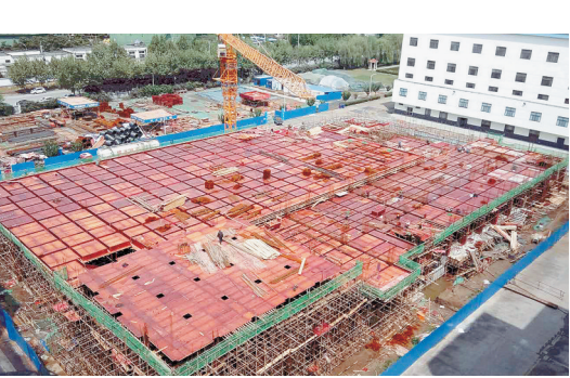
兖州区大店镇坚持“工业立镇、工业强镇”发展理念，聚焦新旧动能转换，全方位服务重点项目建设，推动传统产业改造升级，力促企业提速增效。图为益海嘉里750吨小麦加工项目建设现场。
