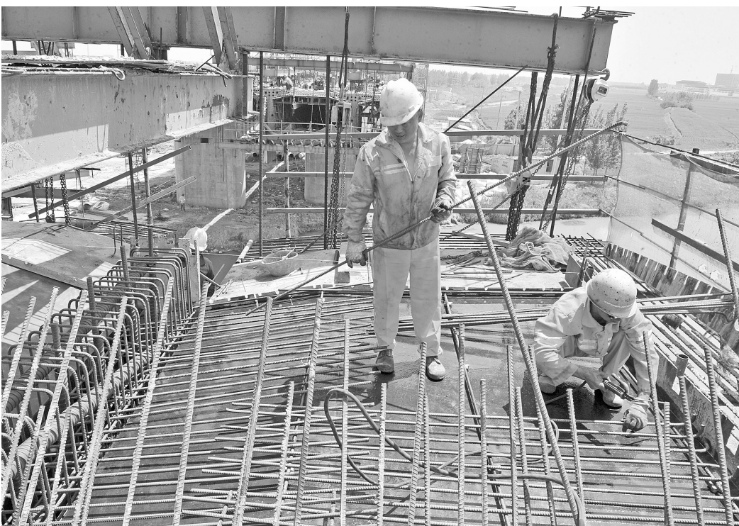
今年以来,我市突出大路网、大港航、大物流、大枢纽、大网络建设,加速形成布局完善、结构合理、快速高效、衔接顺畅的交通基础设施网络。图为G327连国线任城孟庄至嘉祥邵官屯段改扩建工程江庄洙水河桥施工现场。 ■记者 刘项清 摄
