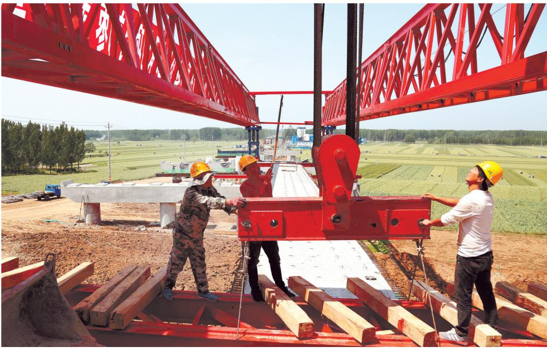
5月3日，枣菏高速南四湖特大桥首片35米预应力箱梁顺利完成架设，标志着枣菏高速建设步入快速推进阶段。南四湖特大桥东起两城镇黄山三村，分别跨越白马河三级航道、京杭运河二级主航道、京杭运河三级西航道以及湖西大堤，西至鱼台县张集镇，南四湖特大桥全长9.889公里。 ■通讯员 李捷 摄
