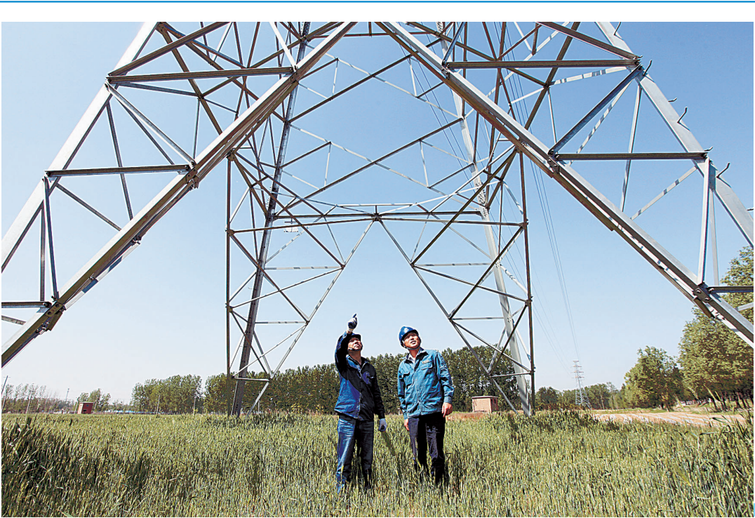
5月3日,梁山县供电公司员工巡视110千伏梁北Ⅰ线杨营分支1号至29号铁塔,检修维护110千伏北关变电站1号主变压器调压机构箱,发现的危险点或安全隐患,立即组织人员进行消缺,全面消除安全隐患,确保度夏期间电网安全稳定运行和电力有序供应。 ■通讯员 吴敬华 摄
