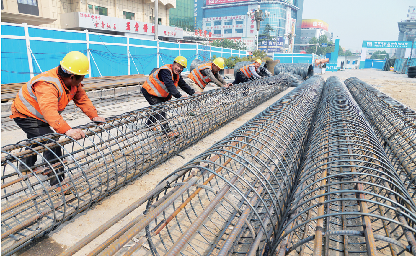
劳动最光荣,劳动最美丽。“五一”劳动节期间,我市许多行业的劳动者依然坚守岗位、辛勤工作,他们忙碌的身影,也是节日里靓丽的风景。图为在任城路综合管廊PPP项目施工现场,工人正加快工程建设。
