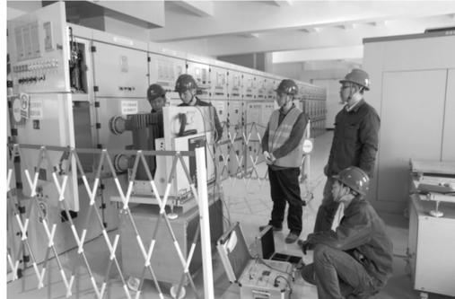
4月8日,梁山县供电公司员工在110千伏杨营变电站对2号主变压器及其附属设备预防性、清扫,对2号主变器10千伏侧断路器试验及维护。梁山县供电公司围绕精益化管理要求,创新春检工作方式和方法,推行标准化春检,严格检修项目计划管理,确保春检工作保持平稳快速推进,不留隐患、不留缺陷、不留死角,保证设备检修质量优良可靠,安全高效完成检修任务。
