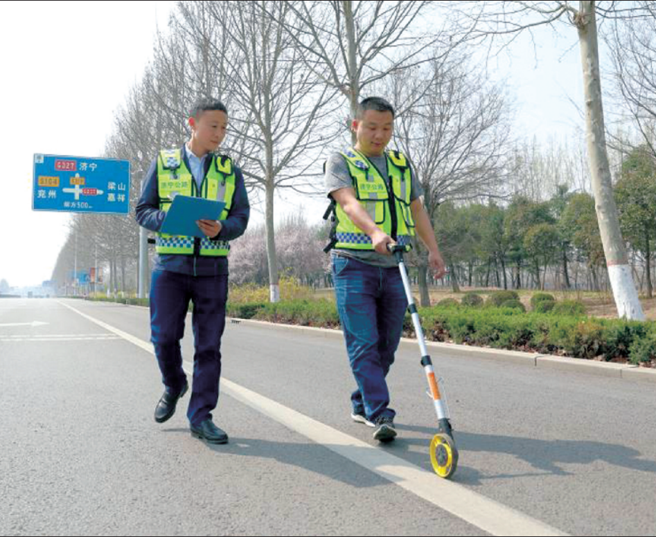
市公路管理局针对春季干线公路养护特点,抓住春季养护有利时机,以强排查、保畅通、树形象为抓手,早谋划、早安排、早动手,认真组织技术人员进行路况检测,避免坑槽、裂缝等病害的发生,全力打造畅安舒美的公路通行环境。图为路况调查现场。
