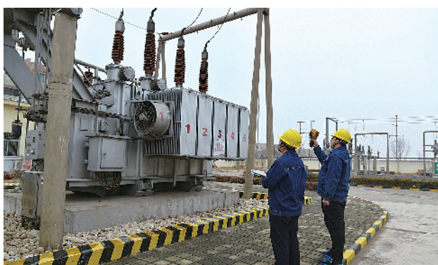
春雨悄悄来临。国网泗水县供电公司根据春节供电方案，采用“逢雨必查”的工作方法，对 110 千伏泗城变电站、中兴变电站，境内 220 千伏八圣线、果圣线等属地化线路开展特巡消缺工作。节日期间，380 余名干部职工全部在岗，顺利实现“三零”目标，圆满完成春节供电任务。 ■通讯员 闫红鹏 摄
