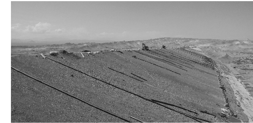
卡回水库建设现场。
