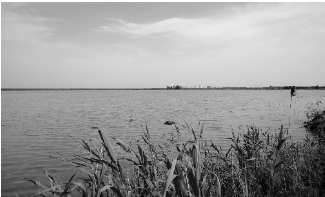
济宁截污导流工程蓄水区。
