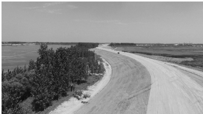
泗河防洪堤防工程。
