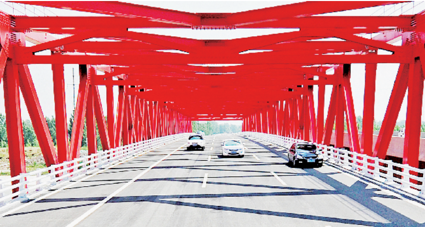
济董线火头湾京杭运河钢桁架桥。
