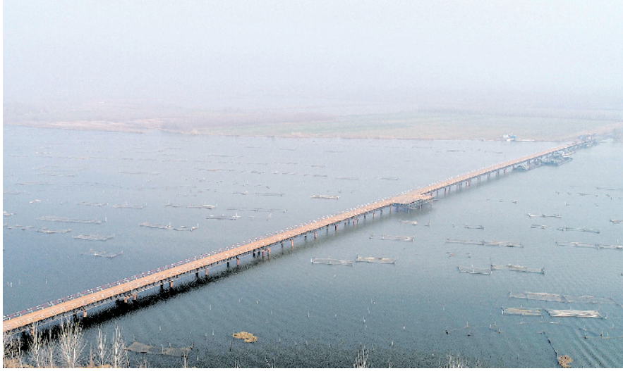
跨湖高速公路建设进展顺利推进有力。
