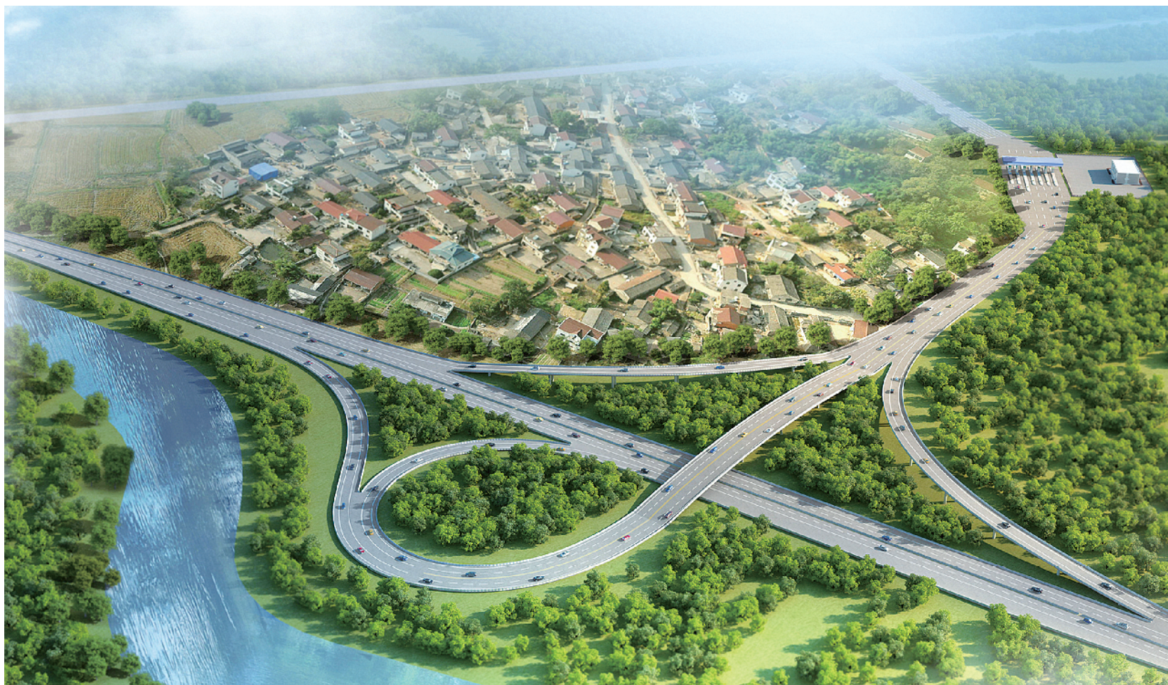
济徐高速太白湖互通立交工程
