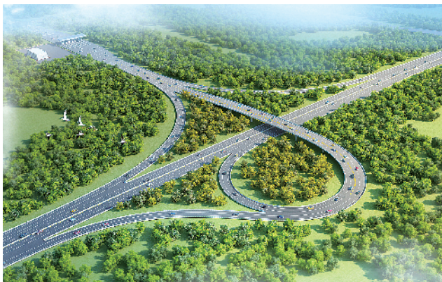
日兰高速曲阜东互通立交工程
