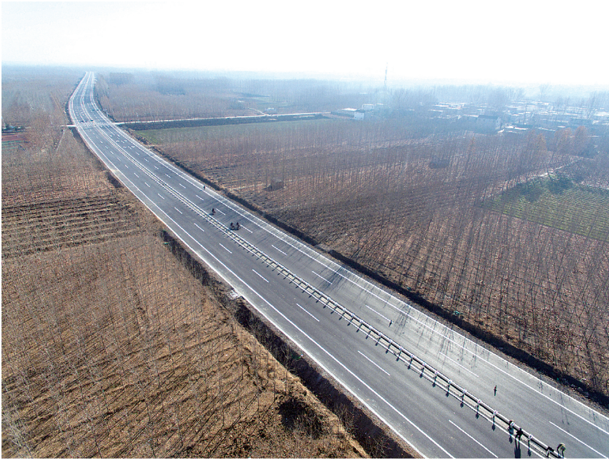
北二环东延工程
