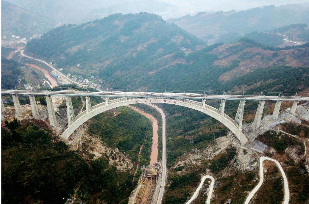
1月11日，一列动车组列车驶过夜郎河大桥。经过5年多艰苦建设，世界首例“贯入式大体积嵌岩拱座基础”大桥——夜郎河特大桥近日落成，与即将开通的渝贵铁路一起进入检测试运行阶段。夜郎河特大桥位于贵州省遵义市桐梓县境内，是渝贵铁路重点控制性工程之一。桥上线路为双线，主桥采用X形“提篮式”拱桥设计，最大跨度370米，为国内同类型桥梁跨度第一。
