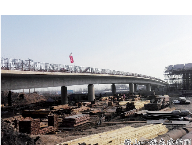
微山一线在建船闸
