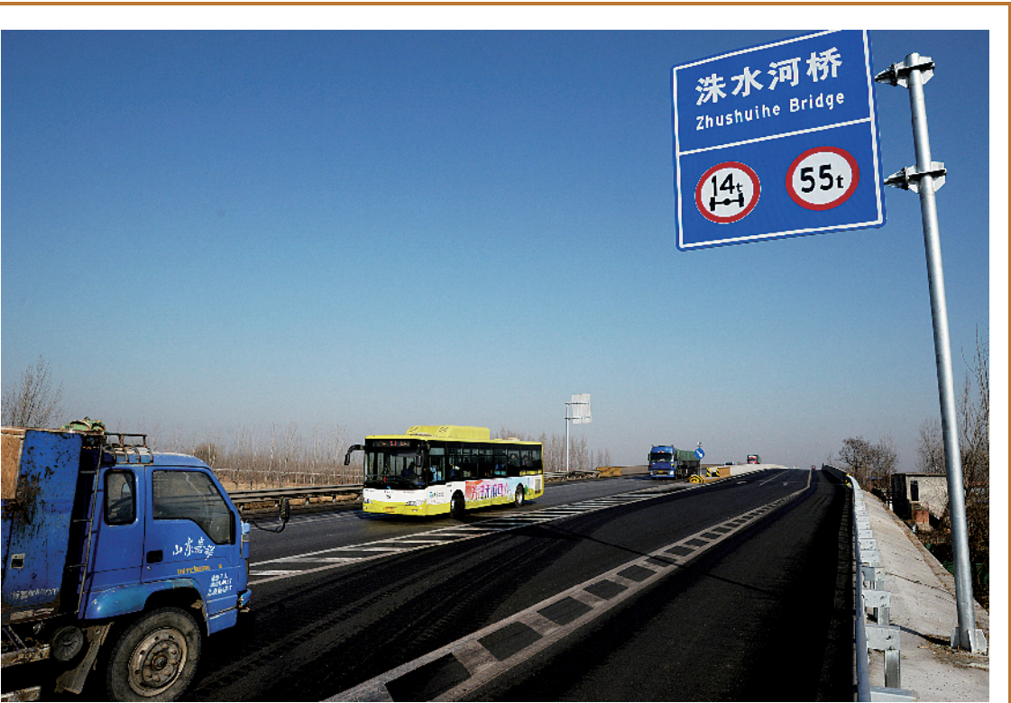
12月20日，S251 济鱼线洙水河桥改造工程提前完工，洙水河大桥双向车道全部通车。据了解，该桥改造采用双向四车道一级公路标准，设计时速80公里/小时，为不影响车辆正常通行，该桥分左右两幅进行施工，右幅已于2016年12月通车。该桥改建通车后，市民出行将更加方便快捷。 ■通讯员 张波 摄
