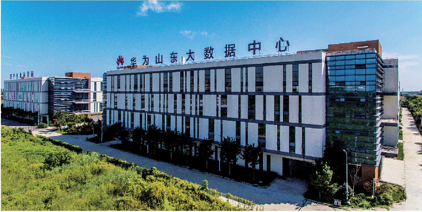
位于济宁高新区的华为山东大数据中心，目前土建改造已完成，预计年底完成机柜安装，整个机房建设采用 T3+ 数据中心标准，可容纳 1064 个机柜，全年运行因故障中断的时间少于 1.5 小时。大数据中心预计明年 3 月上线，建成后将面向山东省提供中立的驻地云、公有云、混合云等服务，作为华为企业云的重要节点、资源节点和产业节点。 ■通讯员 臧盛博 摄
