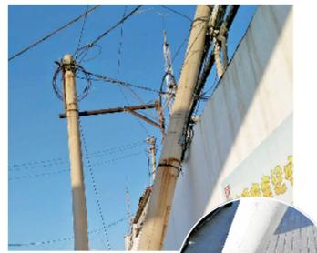
近日,记者途径皇管路发现聚源热力西墙的一根线杆十分危险。该线杆立在人行道的路牙石间,根部断裂,碎石散落一地,斜歪在一旁墙壁上,顶部靠着墙壁上方的管道,不仅危险也影响着行人的出行。希望相关部门及时处理,消除安全隐患,恢复人行道正常通行。
