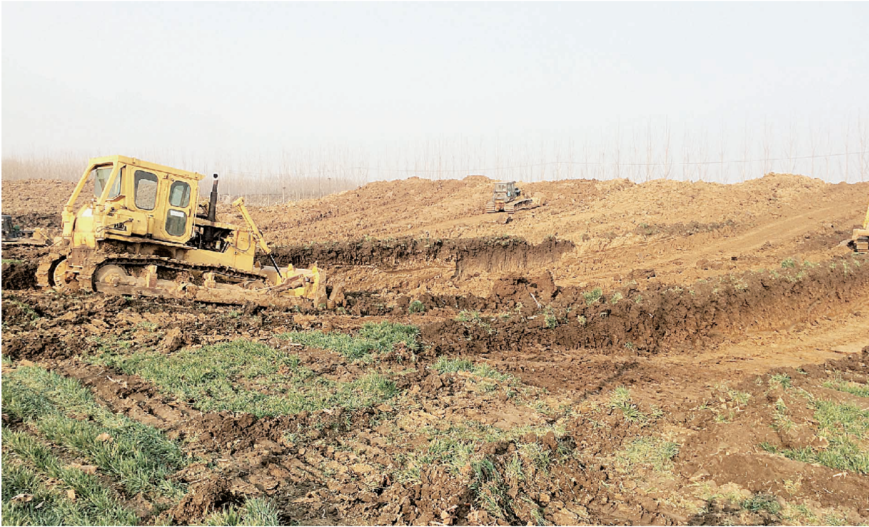
许厂煤矿采煤塌陷地综合治理施工现场
