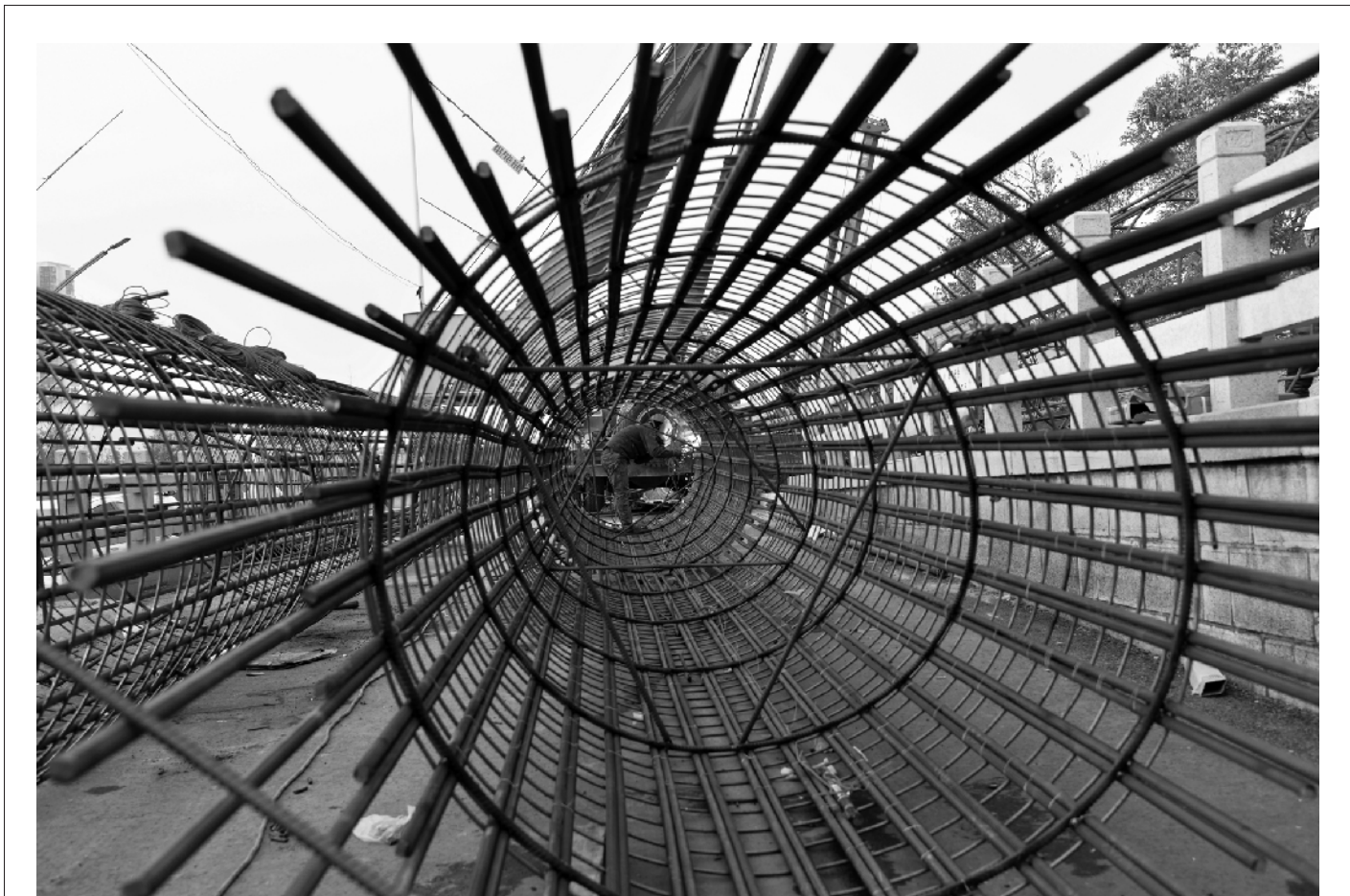
近年来,我市不断加大和完善交通基础设施建设,切实加大资金投入,努力打造整洁优美、安全有序的道路交通环境,交通基础条件得到明显改善。图为火炬路跨日菏铁路跨线桥施工现场。
