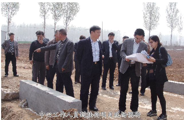
中心工作人员到挂钩项目现场调研
